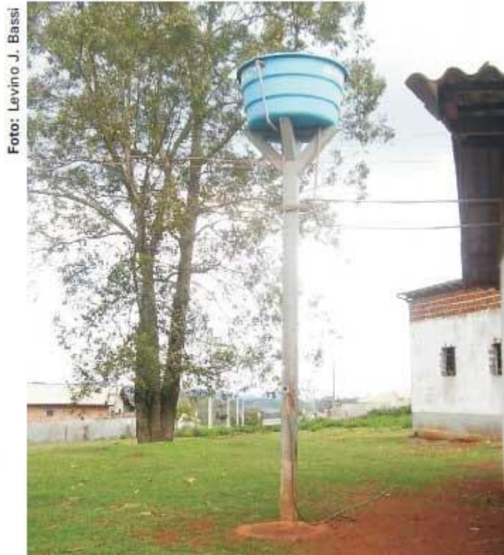
Fig. 6. caixa da água exposta ao sol.
